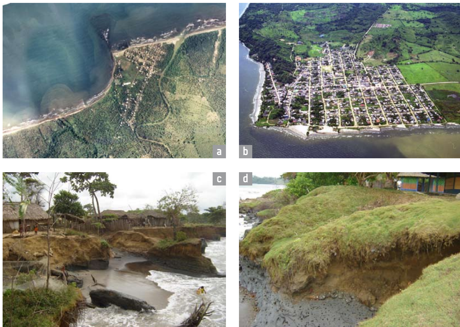
Figura 6.55. a y b) Fotos aéreas de Damaquiel y Necoclí donde se observan los espaldones construidos para protegerse de la erosión marina (fotos Alcaldía Municipal); c y d) En el corregimiento de Zapata (Necoclí) los acantilados son atacados en la base por las olas y además surcados por la escorrentía; las viviendas que se localizan al tope de éstos se hallan en riesgo inminente de colapsar, como ya se observa en algunas de ellas (fotos CORPOURABA).
